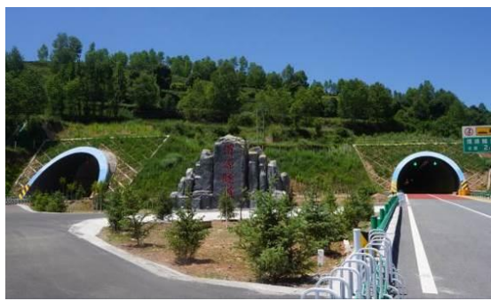
渭源隧道边坡植被恢复
