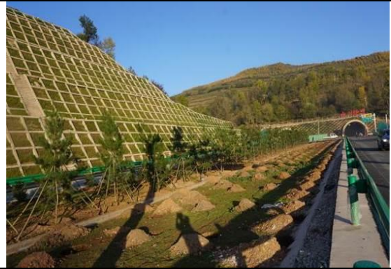
会川隧道口边坡植被措施
