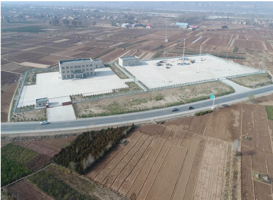
临洮县玉井养护工区无人机监测
