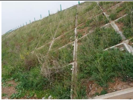
路基护坡植被措施
