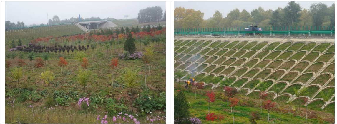
路基护坡植被措施
