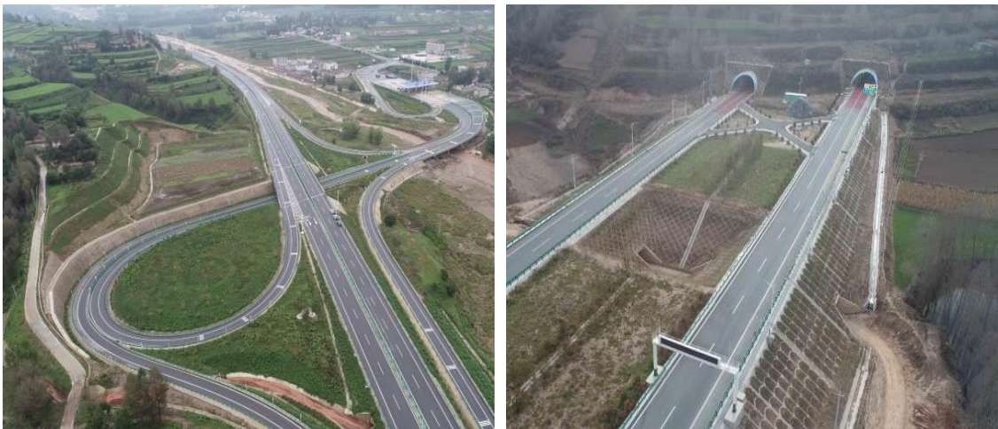
渭源互通立交和渭源隧道出口
