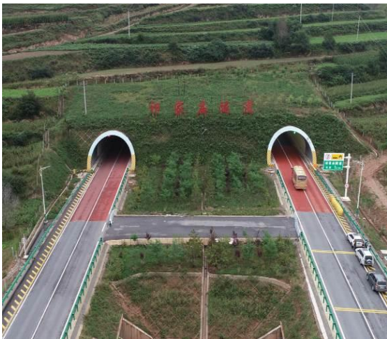
祁家庙隧道进口
