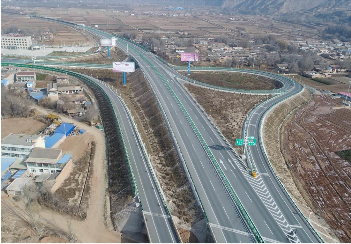
临洮县玉井互通立交无人机监测
