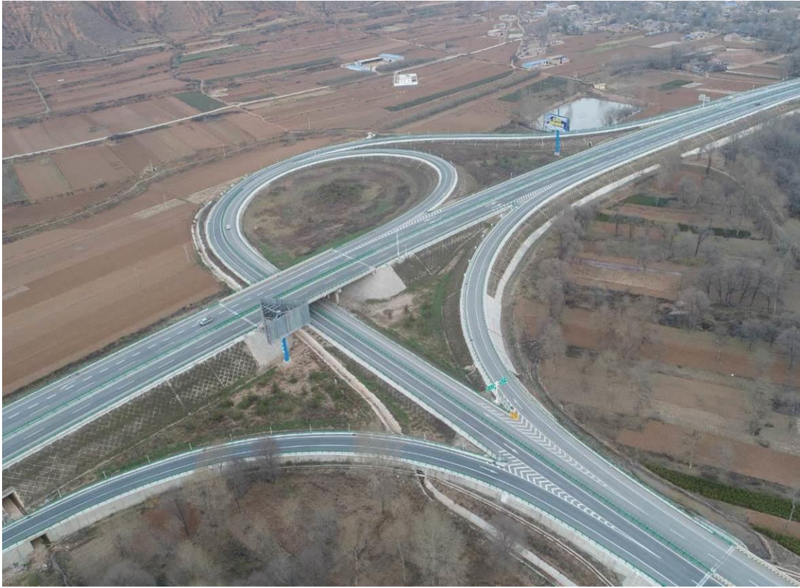
渭源互通立交无人机监测
