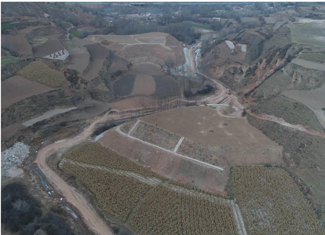
7#弃土场、8#弃土场 (K137+650) 无人机监测
