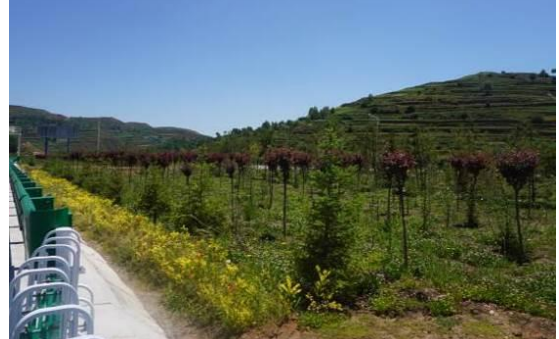
渭源隧道出口路基量测植被恢复
