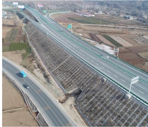
MK91+577-MK92+390 路基骨架护坡防护
