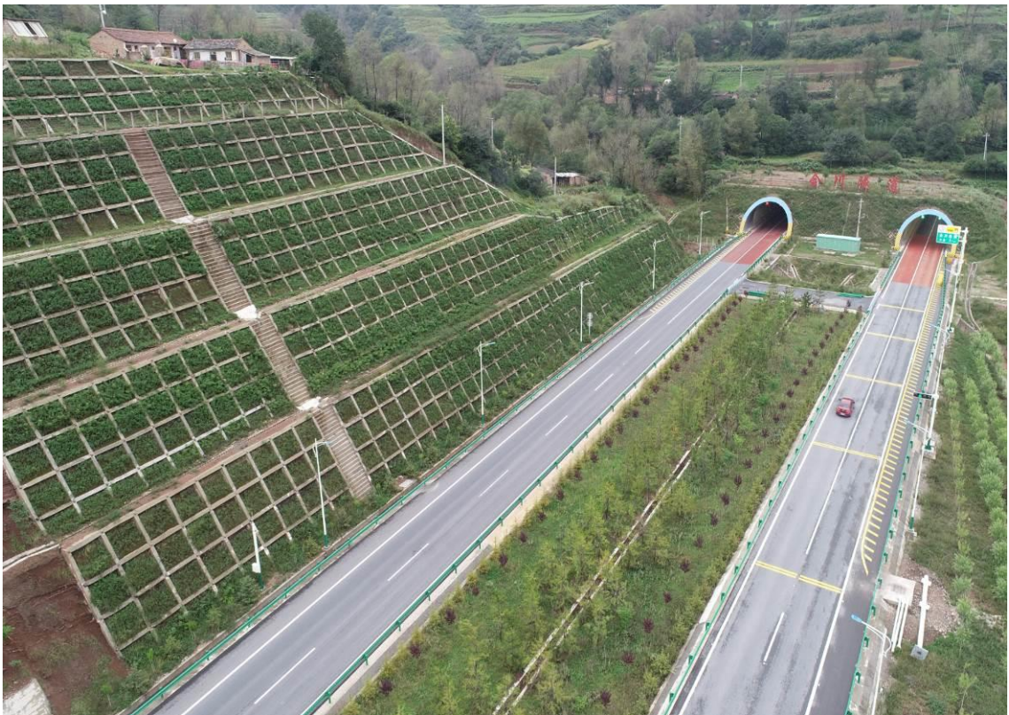
会川隧道入口无人机监测
