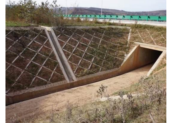
祁家庙隧道路基过水涵洞边坡植被措施
