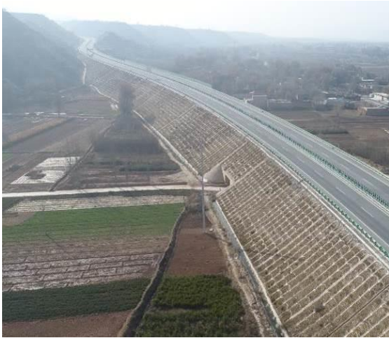
MK91+577-MK92+390 路基骨架护坡防护
